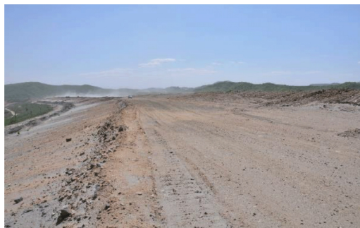
(a) 尾矿库坝顶
