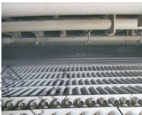
图 2 管式除雾器
