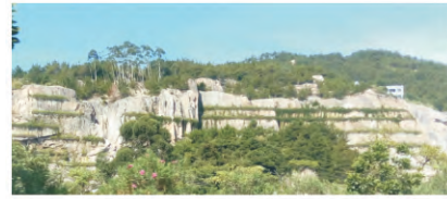
图5 南安市石壁石壁分层绿化治理效果
