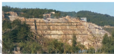
图4 南安市石壁V型槽法石壁绿化工程
