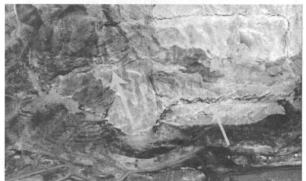
图5 地裂缝影像特征
