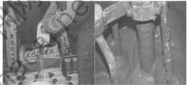
② 视部位按方案所给配料比例,先将水和液料混合搅匀,然后倒入粉料,用搅拌器或类似器具搅拌均匀为止。注意:由于材料配比严格,只有在此配比条件下,材料才能达到最佳反应,故开始搅拌后,禁止向其中掺入粉料、液料或水。
