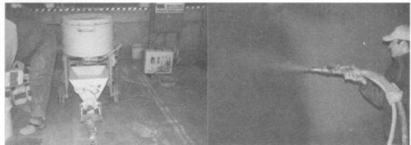
④ 间涂:底涂施工 24 h 后,可进行第二遍(间涂)喷涂或涂刷。涂刷前,将底涂层用水湿润。施工后 24 h 内,涂层上不允许洒水,以免破坏涂料内的化学反应过程,使材料的功能降低甚至失去功效。
