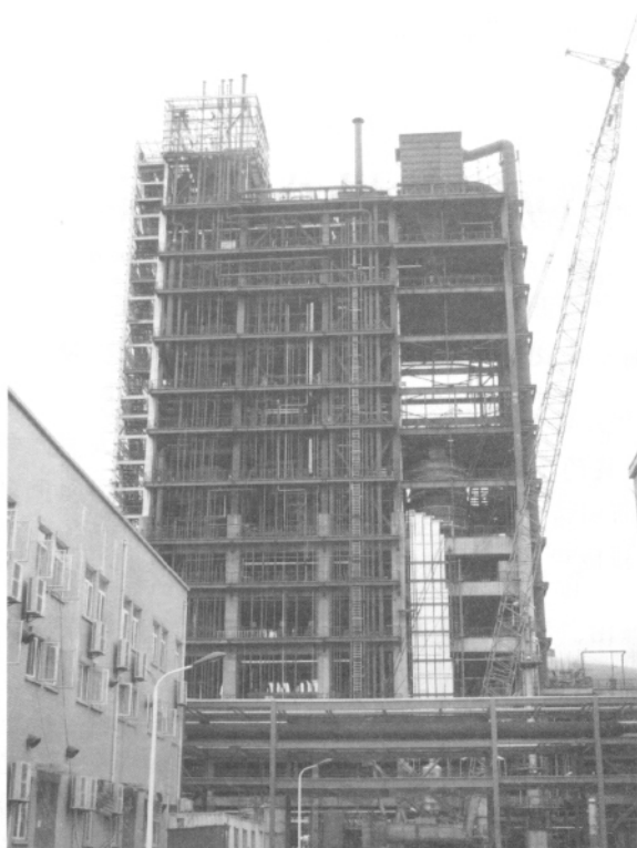
图1 为某建设中的 SHELL 煤气化装置
